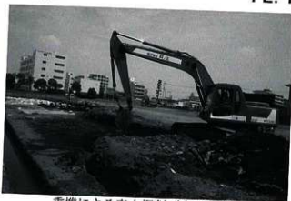
重機による表土掘削（南西から）
