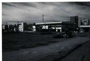
重機による埋め立て作業風景（北東）
