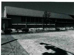
ガードフェンス設置状況 (一南東)
