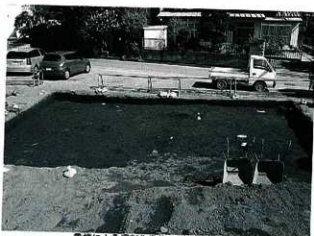
重機による掘削作業終了状況(一前)
