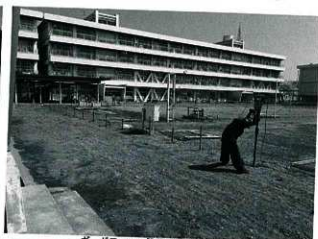
ガードフェンス設置風景 (一南西)
