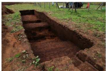
5 4トレンチ 北東から
