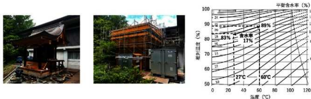
図1 検証に用いた神社本殿建築(左、日光社寺文化財保存会)、断熱覆い屋と制御ユニット(中)、温湿度制御の根拠となる平衡含水率曲線(右、初期含水率17%を保持するように昇温・加温、降温・除湿した)
