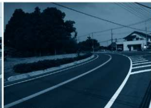
道路整備後の状況
