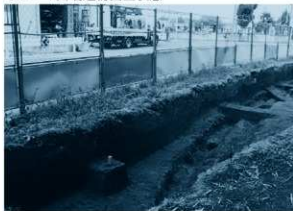
1 区西端 S Z - 5 断面の状況
