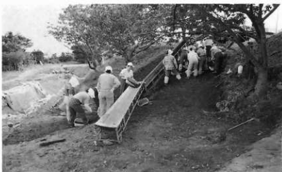
2 三本松土居南側調査状況コンクリート製道路があり電気ビックで除去
