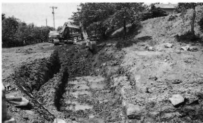
2 外堀をバックホー により堀底部へド ロ層上面まで開削
