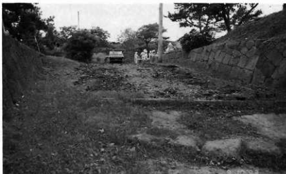
1 簡易舗装を剥がした段階での調査前 状況
