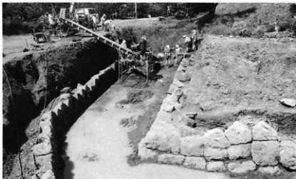
1 外堀の掘方及び石垣が明らかになる
