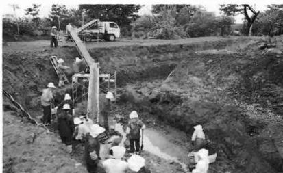
3 バックホーによる 開削後へドロ層及 び掘方を調査
