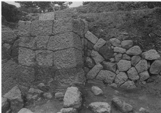
外堀終端部(東側より)
