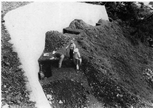
修理箇所根石調査状況
