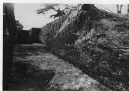
空壕(東側より)
