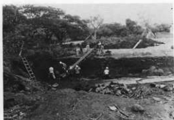
内堀調査状況
