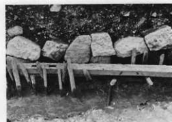
内堀西側杭・角材検出状況
