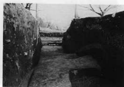
空壕(西側より)
