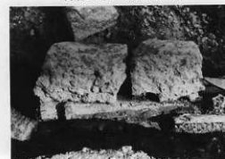
内堀東側石垣・桐木検出状況
