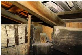
なかのま（じろんま）の南東柱最頂部のほぞ跡
