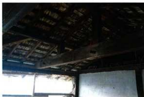
2階の小屋裏に残る転用された隅木
