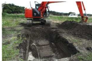
T26 トレンチ全景 (南から)
