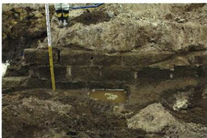
T3トレンチ出土の第1期堤防表法の 礫石積（布積）（西から）
