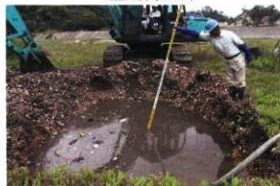
T6トレンチ全景(南から)
