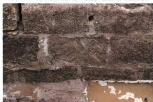
T3トレンチ出土の第1期堤防表法の埋石積 (布種) 拡大 (西から)
