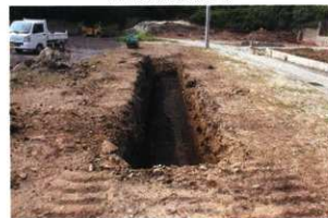
T 5トレンチ全景（東から）
