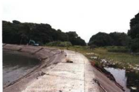
調査区遠景(東から)
