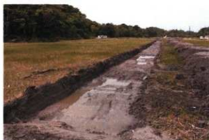
T5トレンチ (南東から)
