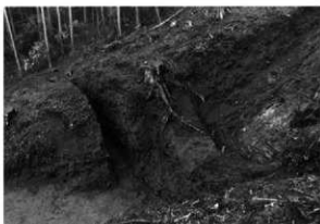
トレンチ7北側部分セクション（南西から）
