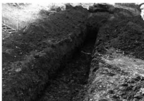
トレンチ12セクション(北から)
