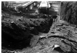
縦堀完掘状況（北東から）
