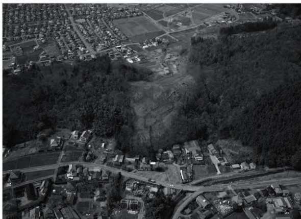
菅田古墳群全景（北上空から）
