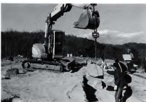
重機による石材吊上げ
