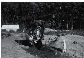
重機による表土掘削
