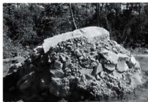
菅田30号墳 石室背面の裏込め (西から)
