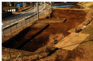
7 B区全景（南東から）
