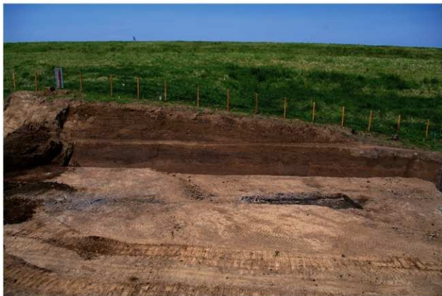
1 旧堤防跡土層断面 (1)
