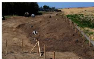
8 旧堤防跡現況 (2) (南東から)
