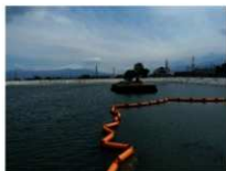
龍地大溜井（池）
