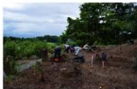
写真1 人力による表土除去
