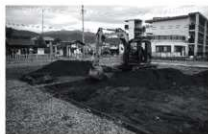
写真3 表土剥ぎ 掘削状況
