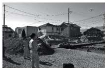
写真4 測量調査委託 実施状況
