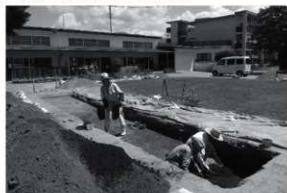
写真1 平成26年度試掘状況
