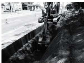
興聖寺城跡重機による表土除去風景
