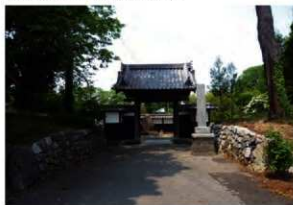
東門付近（東から）
