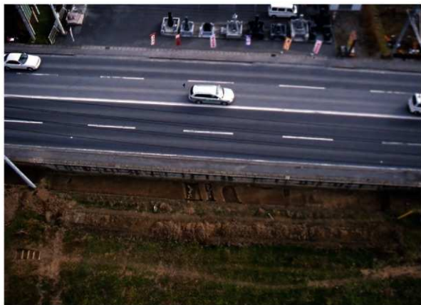
西2区北垂直全景（上が東）
