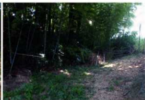
北側土塁・外堀跡（東から）
