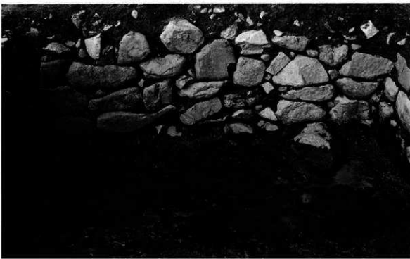
SF3735の北側壁 (南より)
