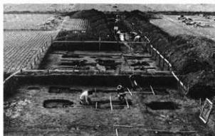
第20図 SB20・24付近調査状況
