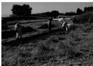
図版 11. 作業状況
