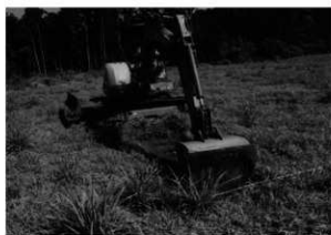
図版 12. 重機使用状況
