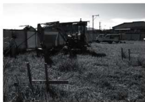
図版1. 重機使用状況(表土掘削)
