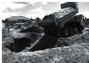
図版2. シラスを用いた埋戻し
