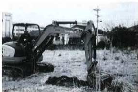
図版6. 重機使用状況
