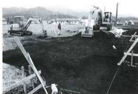
図版1. 工事立会状況
