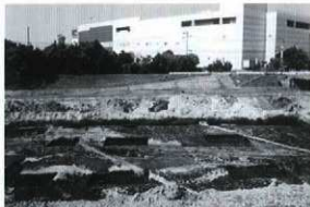
図版 4. 工事立会:1区北側(東から)
