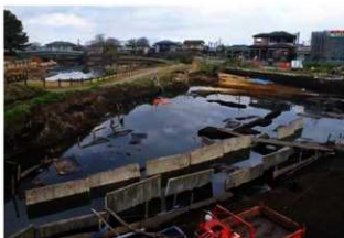
調査区水没状況
