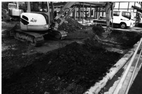
1. 旧郵便局跡の攪乱土層を重機で掘削している。
