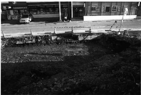
3. 完掘状況 砂利層の上面まで を掘り下げた。
