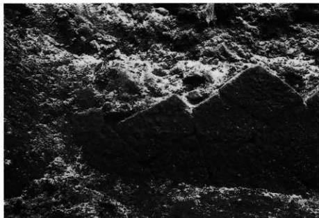
1. ▷外堀三ノ丸隅石垣
