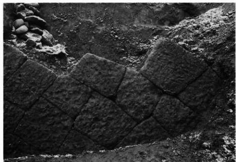
3. ▷外堀三ノ丸隅石垣：岩盤の 削り出し面が、石垣後方に見える。
