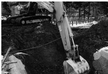
1. ▷重機により外堀を掘削している状況。
