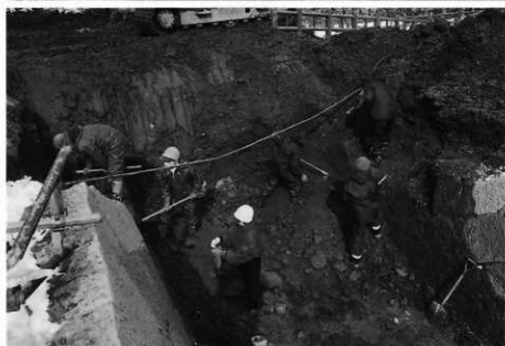
2. ▷人力で両側の土砂を落とし重機ですくい上げる。
