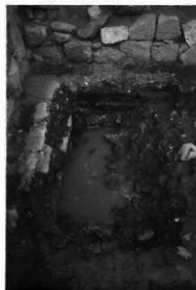
4. △左側に接して石製井戸枠が埋設されていた。地下からの湧水は少なく、ほとんどが暗渠と石垣間から出てくる。地元の人「御前水」と称し、城近まで飲んでたと云う。
