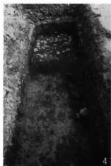
3 2よりもう一段掘り下げると、基 壇地盤下層部の密まわりに砂利を 敷いている。4も同様。
