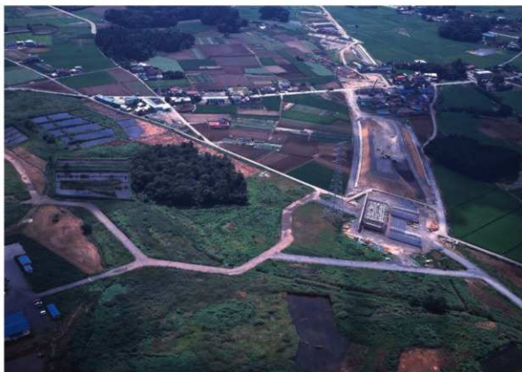
SG5区 全景(北東上空から)
