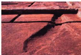
SG2区 D区流路5 東半部土層断面(東から) 中位はFA層
