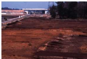
SG5区 低地西北部(南から)
