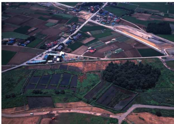
SG5区 全景(東上空から)
