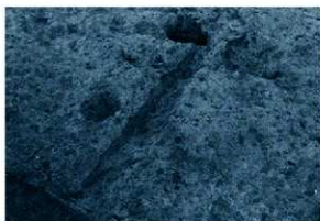
21区S1-1 南西隅間仕切り (南西から)
