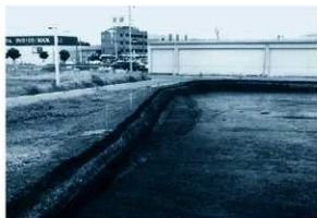
39区SD-8・9 完掘(東から)
