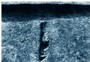
S1-21 間仕切り(D3)完掘(東から)
