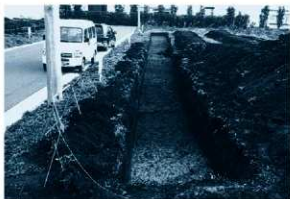
33区SD-1・2・3北側トレンチ 完掘 (西から)
