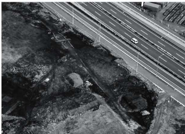
6区·7区东部航空写真(南西上空)
