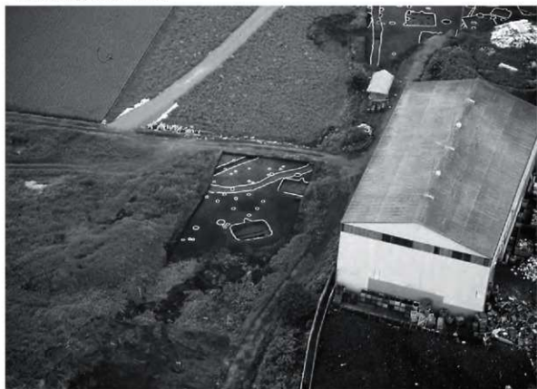
9区南部航空写真(南上空から)
