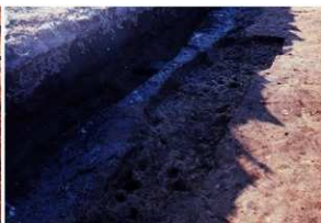
II区 SD-101・121 完掘 (北東から)
