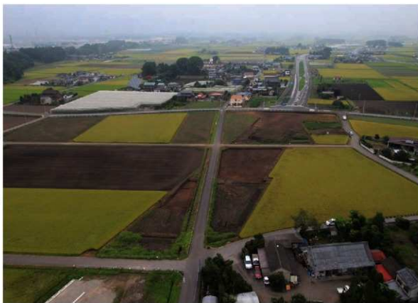
I-4区・I-5区・I-6区全景(南上空から)
