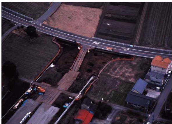
I-2区・I-3区全景(北西上空から)
