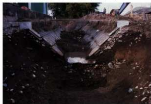
Ⅲ-3区SD-001A-A'セクション(南から)
