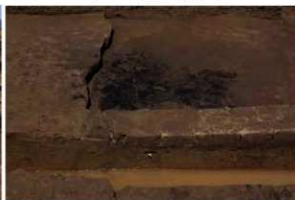
Ⅲ区 SI108 中央覆上下半及び掘方土層断面（南から）
