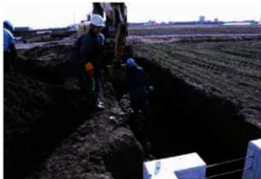
M区水道管理設部立会い(北西から)
