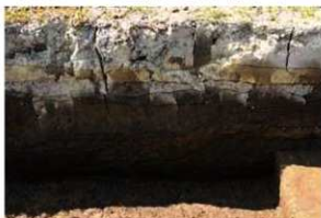
Ⅳ区西半 SD130C 西壁北部土層断面 (南東から)
