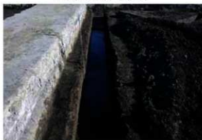
C区トレンチ2 (南西から)
