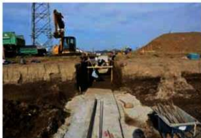
A4区立会い状況(南から)
