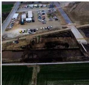
D・E・K・L区全景（南から）
