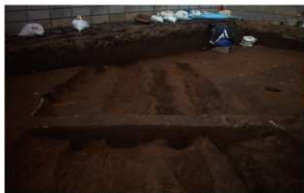
1 21次G区第2号溝跡(2)(南西から)
