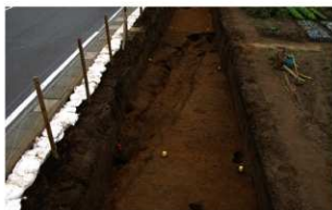
7 27次第1号溝跡全景(西から)
