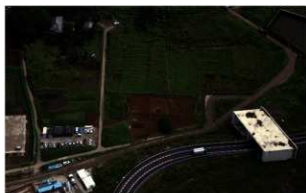
6 第2次調査区（西から）
