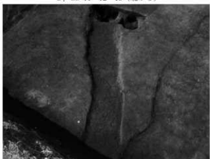
5. SD-17 (南東から)
