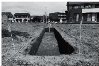
TR-2 掘削状況（南から）
