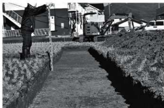
掘削状況（西から）
