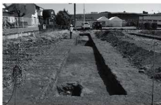
TR-1 掘削状況 (西から)
