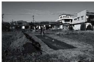
TR-1 掘削状況（南から）
