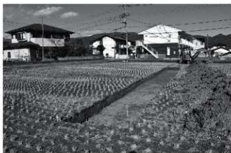
掘削状況（南西から）
