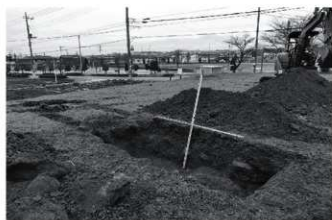
TR-2 掘削状況（北東から）
