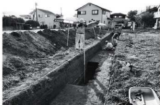
TR-3 掘削状況（東から）
