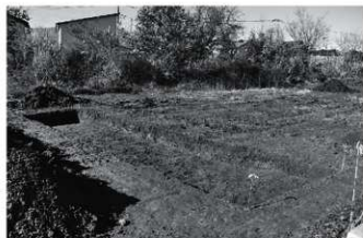
TR-1 掘削状況（南東から）
