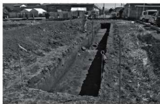
TR-4 掘削状況 (西から)
