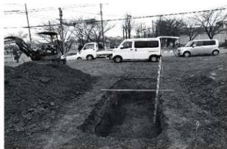
TR-1 掘削状況（東から）
