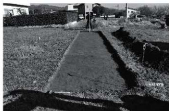
TR-2 掘削状況（西から）
