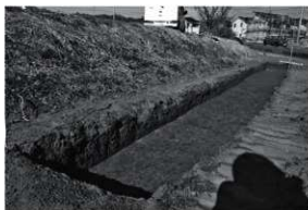
トレンチ3 (南西から)
