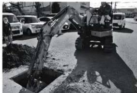
調査風景（北から）
