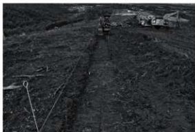
トレンチ掘削風景（北から）
