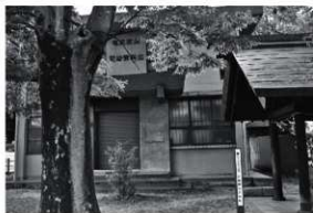
竜王歴史民俗資料館 解体工事着手前状況
