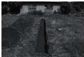
トレンチ掘削状況（南から）
