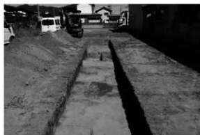
完掘状況（西から）
