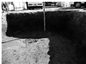
掘削深度及び遺構検出状況（北から）
