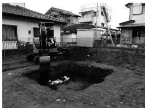
埋め戻し状況（南東から）
