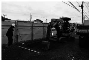
試掘調査 表土剥ぎ
