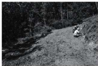
饅頭石確認箇所（東から・左手が饅頭峠）
