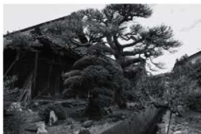
中村家住宅と楯無堰（南東から）
