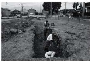
旧資材置場 TR-1 調査風景（東から）
