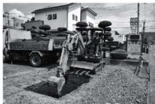
県道西側 掘削状況(南から)
