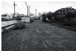
県道東側 掘削前状況(南から)
