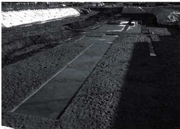
第4面全景（西から）
