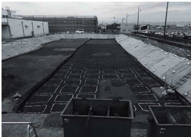
Hr-FA洪水層下水田北側全景（東から）
