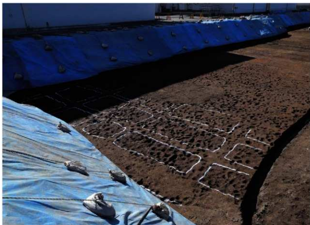
Hr-FP洪水層下水田南側全景（北東から）
