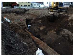
作業風景 (表土掘削)
