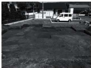
調査状況（南から）
