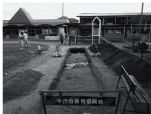
TR-3 遺構養生状況(北から)
