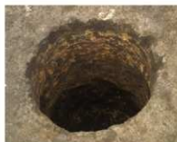
Ⅲ区 SE-77 完掘 (南から)
