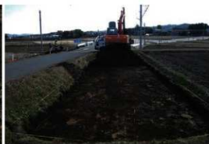
Ⅱ-A区 表土除去(南から)
