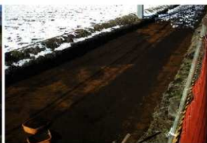
II-B区 SD-06,SI-26 周辺確認(南東から)
