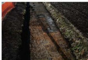
II-B区 SD-49 完掘（北から）
