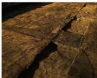
Ⅱ-A区 SK-01 完掘 (南東から)
