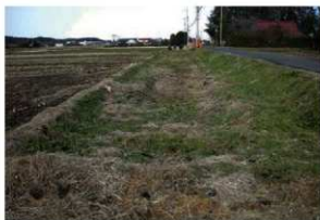
Ⅲ区 現況 (南から)
