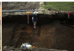
Ⅲ区 SD-88 調査風景（東から）
