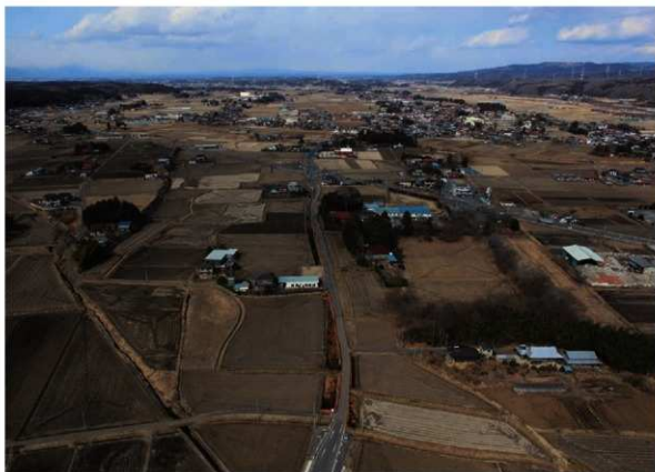
発掘調査区と史跡那須神田城跡（南側上空から）
