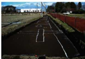
II-B区 SD-06・09,SK-08 周辺確認(南西から)
