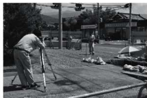
写真3 測量委託 実施状況 (BM設定)
