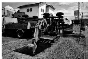
写真2 県道西側 試掘状況
