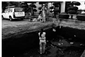
写真4 測量委託 実施状況（県道西側）
