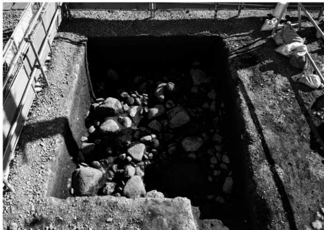
3区A南 完掘（西から）
