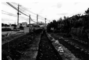
写真1 県道東側 試掘状況
