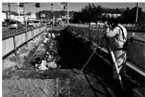
写真3 測量委託 実施状況（県道東側）
