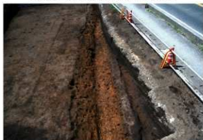
SD-11・12 完掘状況(南東から)
