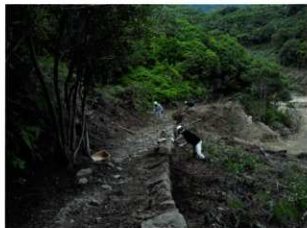
051 作業風景 清掃 (北西から)
