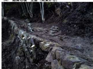
149 路肩石積 立面 (南東から)
