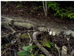
156 路肩石積 立面(南から)
