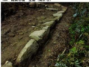
186 路肩石積 立面 (南から)
