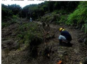
053 作業風景 清掃 (南東から)
