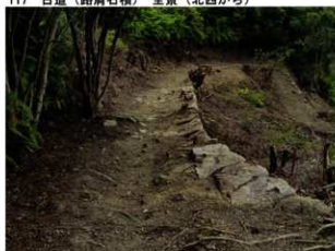
119 古道（路肩石積） 全景（北西から）
