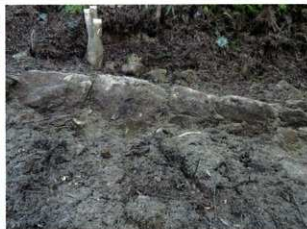
172 路肩石積 立面 (南から)
