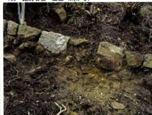
162 路肩石積 立面(南から)
