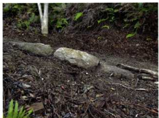
155 路肩石積 立面(南から)
