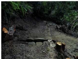
188 石組排水溝 (北西から)
