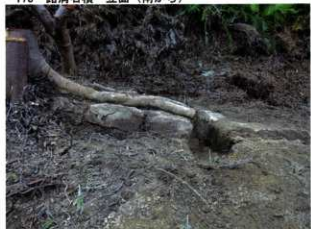
175 路肩石積 立面 (南から)
