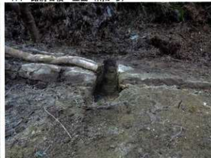
176 路肩石積 立面 (南から)
