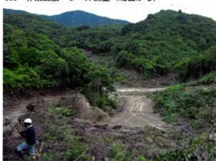
057 作業風景 写真撮影 (北西から)
