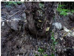
168 路肩石積 立面 (南から)
