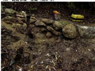
182 路肩石積 立面 (南から)
