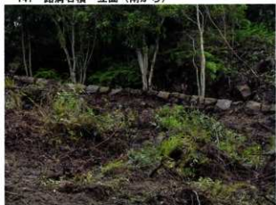
143 路肩石積 立面(南から)
