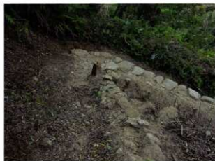
131 古道（路肩石積） 全景（北西から）
