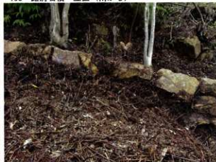
160 路肩石積 立面(南から)
