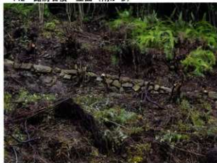
144 路肩石積 立面(南から)
