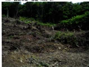
146 路肩石積 立面(南から)
