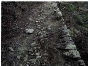
123 古道（路肩石積） 全景（北西から）
