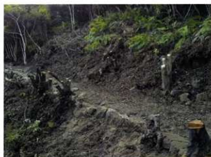
147 路肩石積 立面 (南東から)
