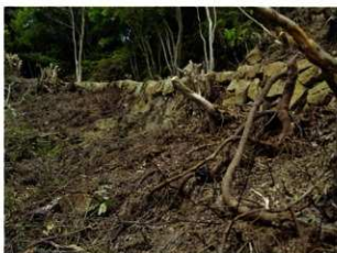
148 路肩石積 立面 (南東から)
