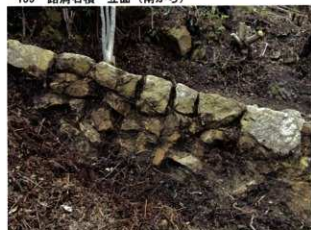
161 路肩石積 立面(南から)
