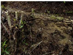
180 路肩石積 立面 (南から)
