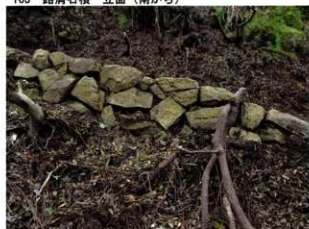
165 路肩石積 立面 (南から)
