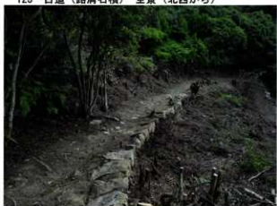
125 古道（路肩石積） 全景（北西から）
