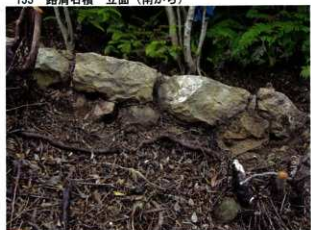
157 路肩石積 立面(南から)
