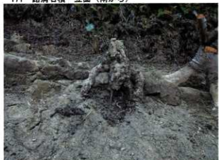
173 路肩石積 立面 (南から)
