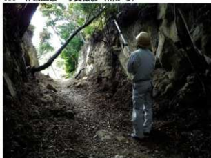
058 作業風景 写真撮影 (南から)
