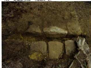
190 石組排水溝 (上から)
