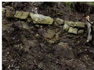
163 路肩石積 立面 (南から)
