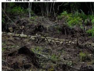
145 路肩石積 立面(南から)
