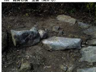
185 路肩石積 立面 (南から)
