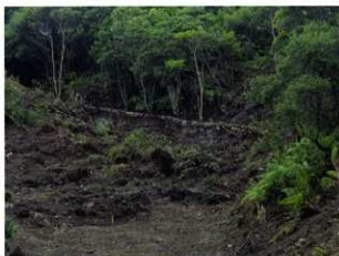
140 路肩石積 立面(南から)
