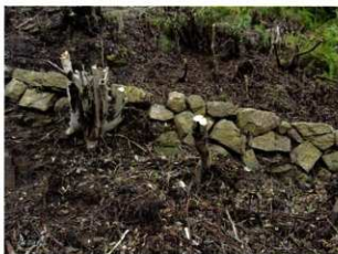
164 路肩石積 立面 (南から)
