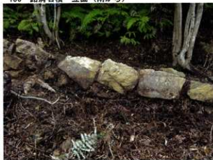
158 路肩石積 立面(南から)
