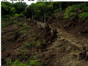
152 路肩石積 立面 (南東から)
