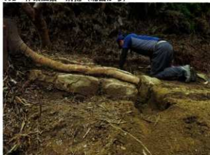
054 作業風景 排水溝調査 (南西から)
