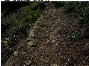
095 清掃前現況（南東から）
