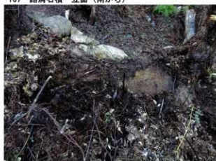
169 路肩石積 立面 (南から)
