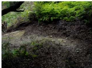
115 古道（路肩石積） 全景（北から）
