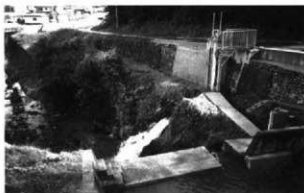
13. ニシノ水路分水(高橋川)
