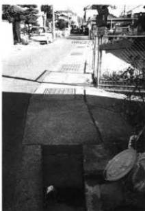
34. 中下溝と隅田川取水路の合流点
