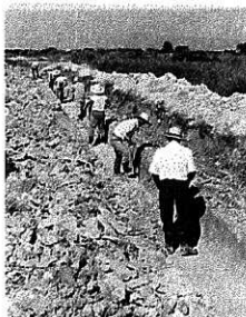
第3図 下層試掘作業風景
