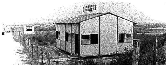
第1図 調査関係者詰所及び標識
